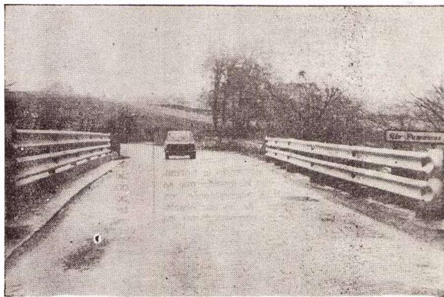
El puente sobre el río Pámanes, que ha sido dotado de nuevas vallas metálicas en sustitución de las endeble barandillas que tenía. (Foto: DEL RIO.)
